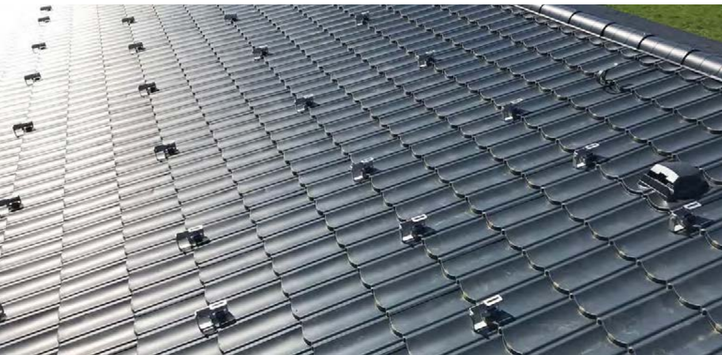
(Foto: Dachdeckerei Burk, Bischoffen)
