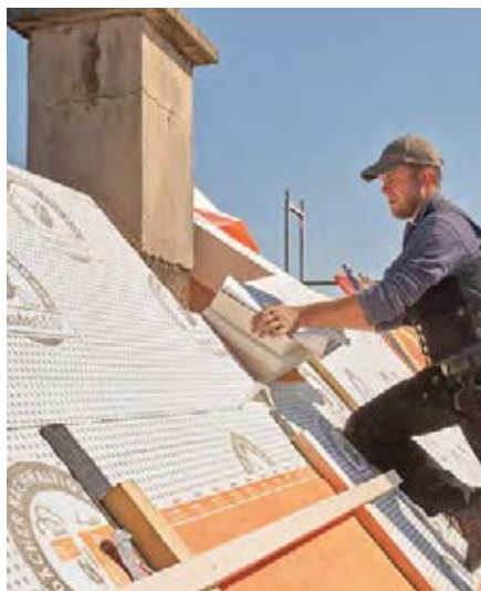
Verlegung BauderECO S
