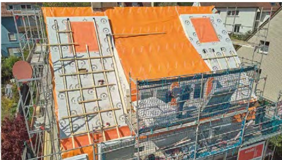
Verlegung BauderECO S
