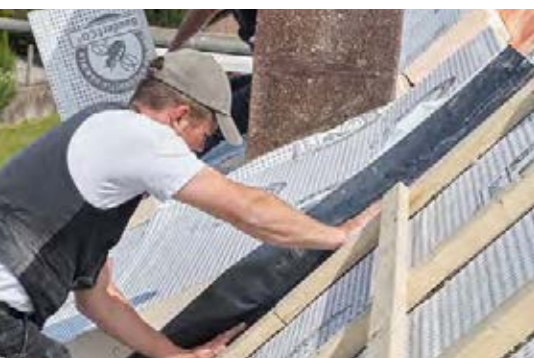
Verlegung BauderECO S
