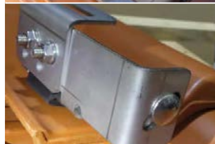
Formschlüssige Einfügung des Solarhalters in den Ziegel
