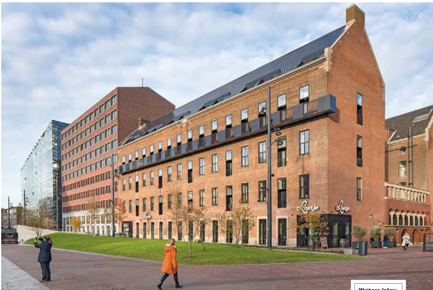
Mitten in Rotterdam setzt der heutige Wohnungsbau die spitzen Dächer der Umgebung fort, findet aber über die in das Steildach integrierte Photovoltaik-Anlage seine ganz eigene Sprache
