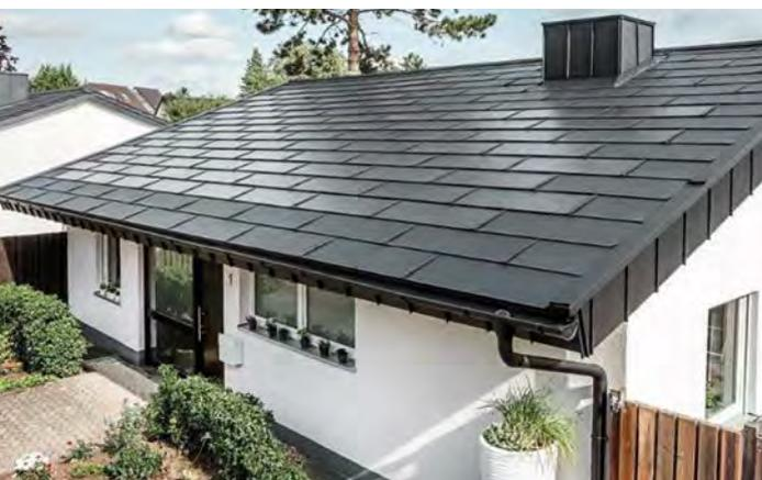
**Die elegante Art, Strom zu produzieren: mit der Aluminium-Dachplatte in bewährter PREFA Qualität und integrierter Photovoltaikanlage**
