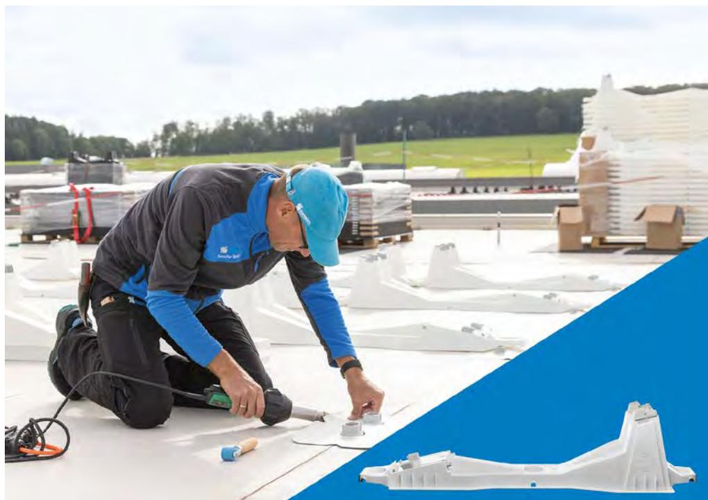
Die PV-Unterkonstruktion SOLAR Alpino ist bis zu einem Kilogramm leichter als vergleichbare Modelle und damit auch für Dächer mit geringerer Traglastreserve geeignet. Sie hält durchdringungsfrei: Als Basis wird eine Grundplatte inklusive Halterung mithilfe einer Bitumen- bzw. Kunststoffmanschette verschweißt. Darauf wird der Modulträger gesetzt und mit einem Drehverschluss gesichert.
