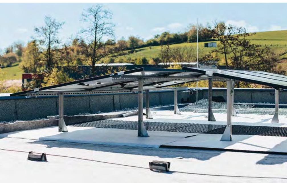
Die aufgeständerte PV-Unterkonstruktion SOLAR Nature von SOPREMA ist eigens für Gründächer entwickelt. Die Ballastierung erfolgt über das Substrat, die Dachabdichtung bleibt unversehrt und wird sogar durch die Gründachschicht geschützt. Auch dieses System ist besonders leicht und lässt sich in kürzester Zeit aufstellen.
