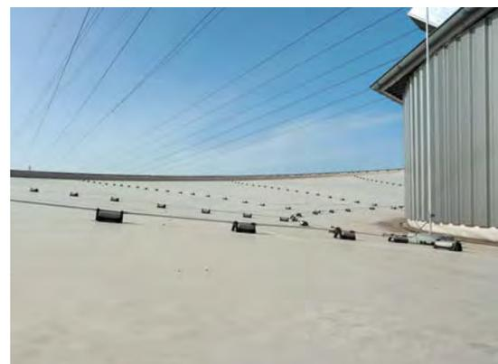
Das Dach wird von einer 4 mm dicken Blechmembran getragen, die auf Zug vorgespannt war
