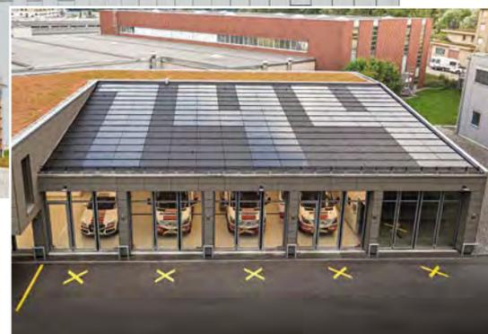
„Sunskin Roof Lap“ Indach-System für Dächer mit einer Neigung von 15° bis 60°
