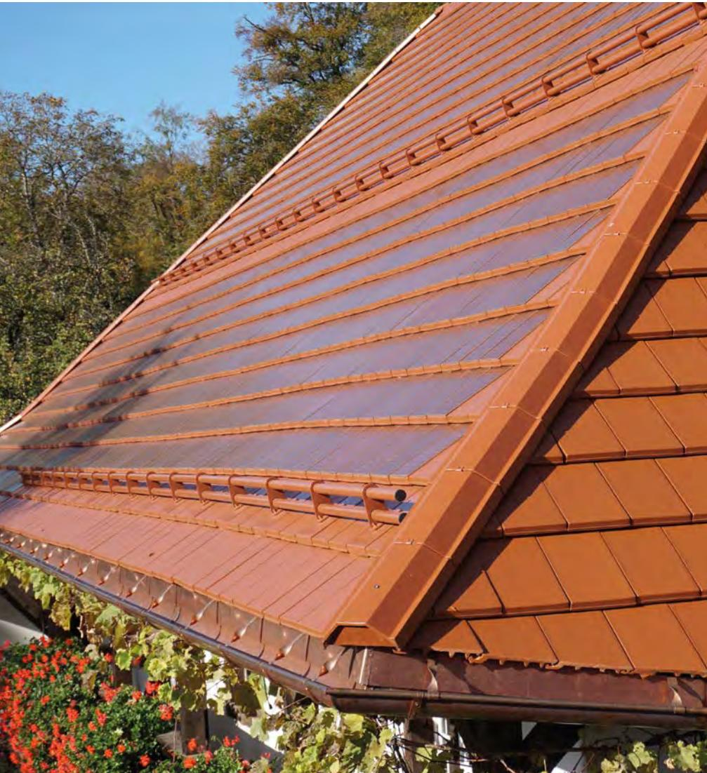
**Dachintegriertes PV-System Vario für rot eingedeckte Dächer verfügbar**
