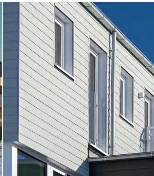
Dank der Hardie® Plank Fassadenplatten ist es dem Architekten gelungen, die außergewöhnliche Architektur des Einfamilienhauses mit einer ebenso ausgefallenen Fassadenoptik zu betonen
