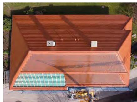
**Das Creaton-PV-Autarq-System kann fast vollflächig auf dem Dach verlegt werden**
