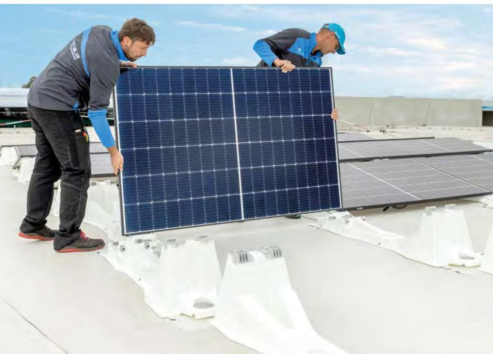
Mit modernen PV-Unterkonstruktionen werden Flachdächer zu Energielieferanten
